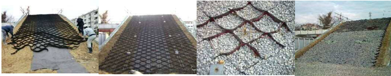
写真1 ジオセル敷設
