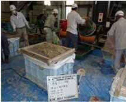
写真1 攪拌土のふるい掛け
