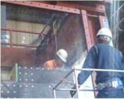
写真4 標点設置状況
