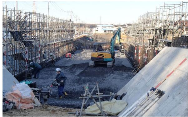
写真-5 施工状況 (締固め作業)
