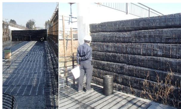
写真-6 工区境での補強盛土の端末壁面
