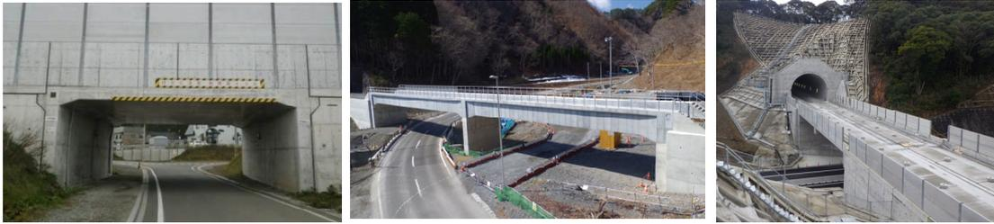
北海道新幹線架道橋 (RC) 三陸鉄道ハイペ沢橋梁 (SRC) 九州新幹線原種架道橋 (PCT 桁)
