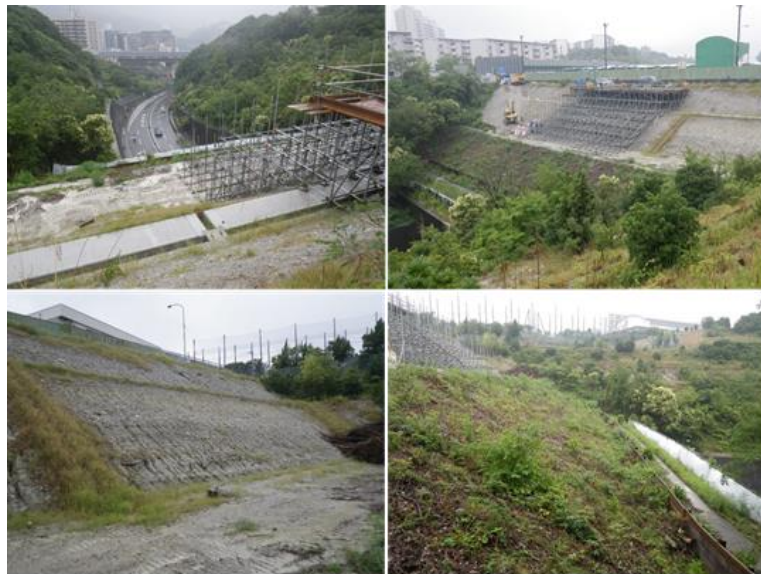
写真-4 現場全景（施工中）
