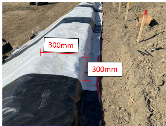
図-8 のり肩付近における遮水シートの固定状況
