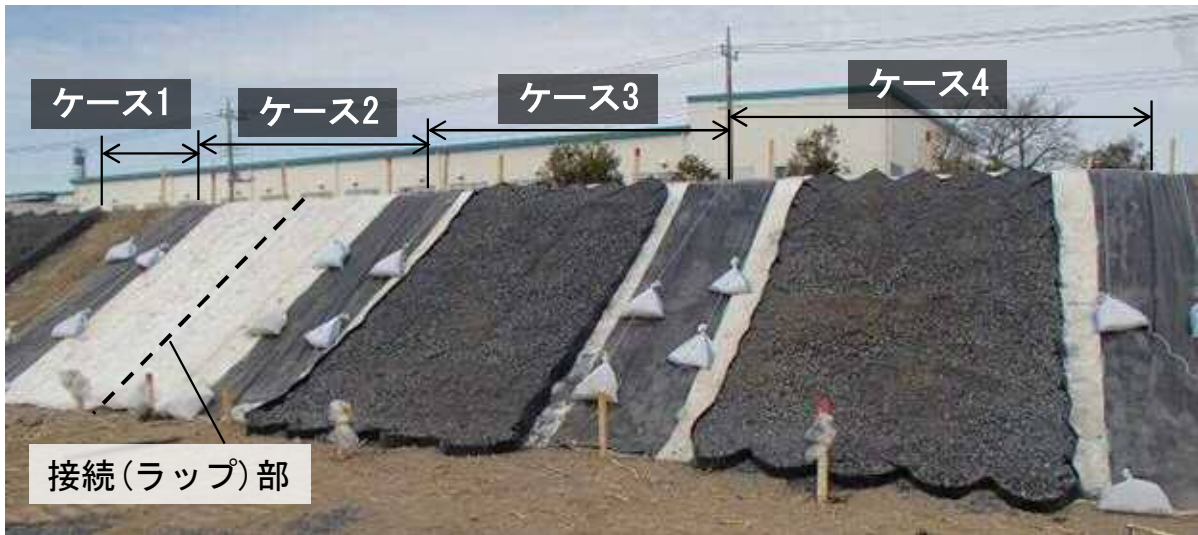
図-2 施工完了時の状況（左からケース1～ケース4）
