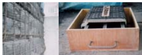
写真 2 溶接金網仮抑え材 (実施工⇔模型)
