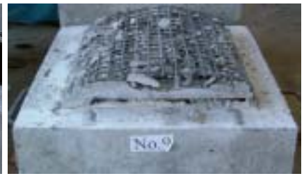
写真 7 定着破壊状況（溶接金網）
