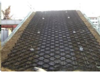
写真2 縦および横筋設置
