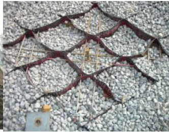
写真3 中詰め工 (アンカー部)
