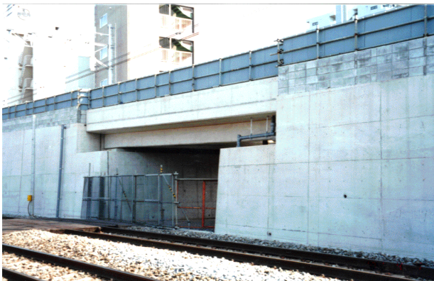
写真9 橋台の完成状況（西武線）
