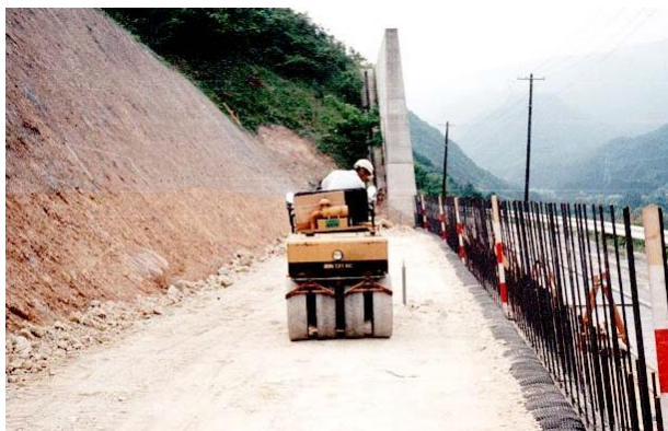
写真3 盛土の転圧状況
