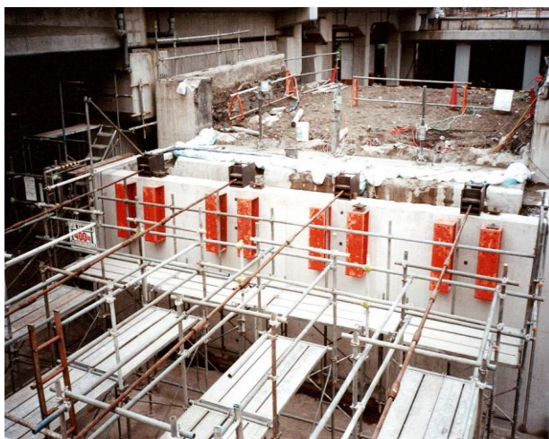
写真10 水平載荷試験状況
