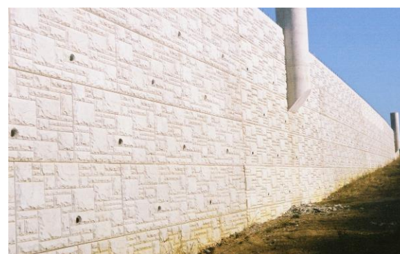
写真5 プレキャスト壁面の完成状況
