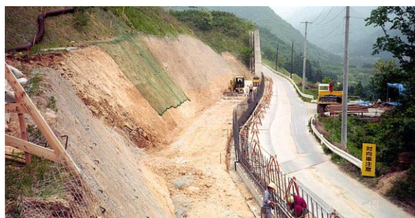
写真6 施工状況（山形自動車道）
