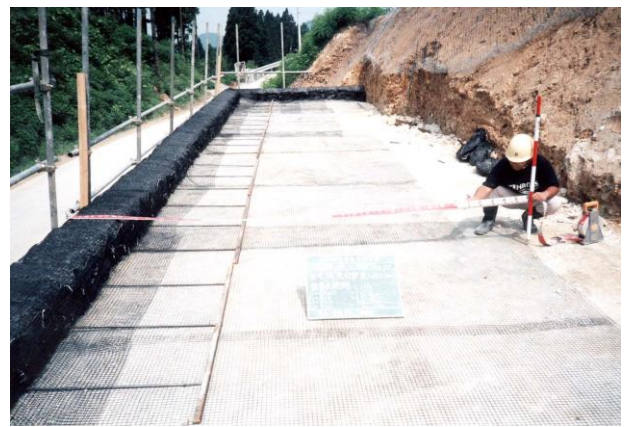
写真1 補強材の敷設状況
