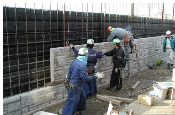
写真4 プレキャスト壁面の施工状況
