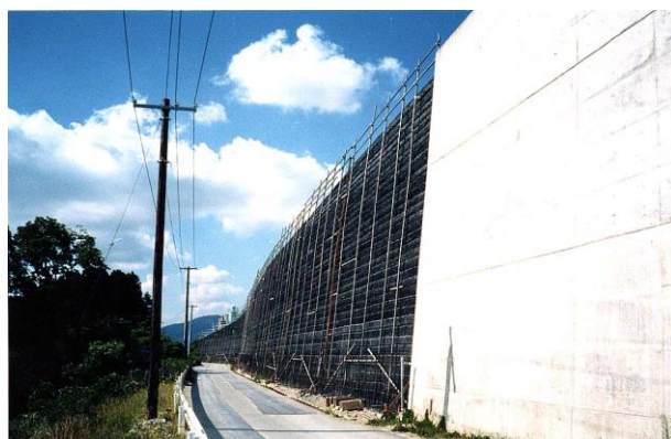
写真7 補強盛土部の完成
