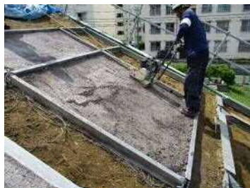
写真-7 締固め
