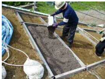
写真-5 遮水材撤出し
