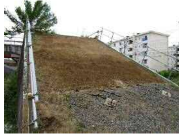
写真-1 のり面整形
