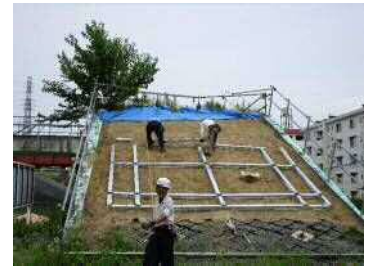
写真-2 鋼製格子枠組立
