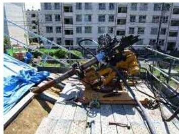
写真-3 地山補強材設置
