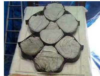
図-6 ジオセル設置の様子
